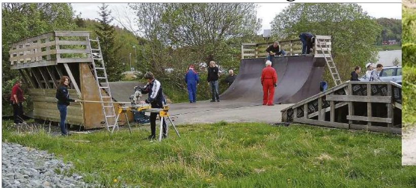
REPARASJONSARBEIDET er utført av Rotary-medlemmer over to mandagkvelder.
